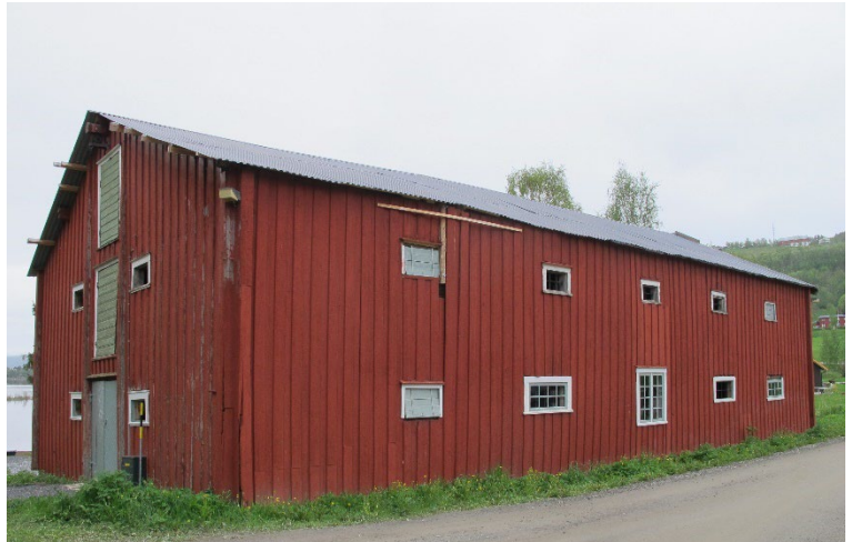
Storbrygga i 2014, etter at taket var sikret og den hadde fått et strøk maling.
