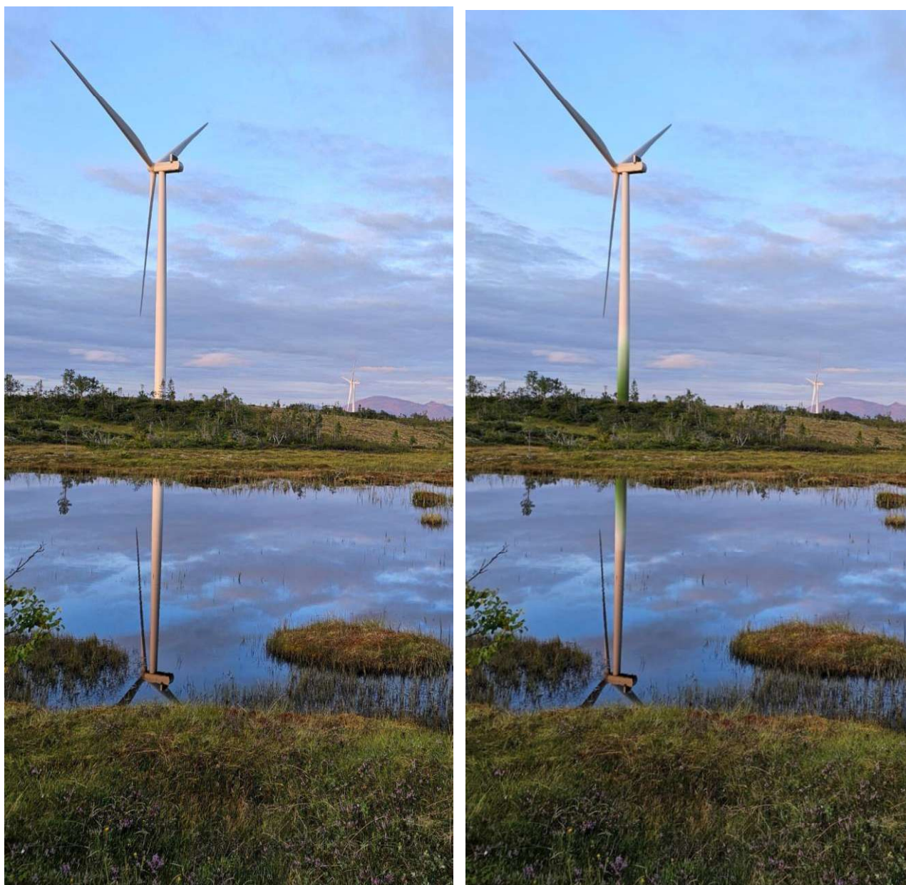
Figur 2-1: Viser eksisterende turbiner på Stokkfjellet, der den fremre turbinen er illustrert med kontrastfarge på bildet til høyre. Den ensfarga hvite turbinen til venstre har et renere visuelt uttrykk enn den med kontrastfarge i nedre del. Grønn med glidende overganger, som vist på illustrasjonen til høyre, er mye brukt når kontrastfarge benyttes på vindturbiner.
