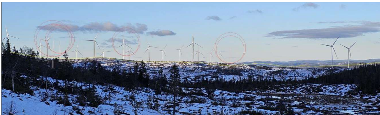
Figur 1-9 En sammenligning mellom turbinhøyde 180 meter og 195 meter er vist ved røde sirkler.
