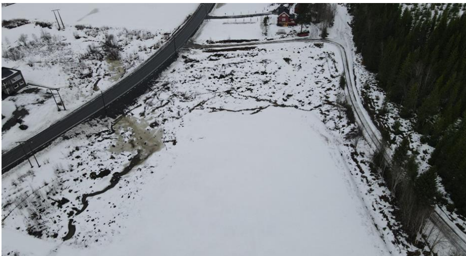
Figur 1.1.4. Bekkeløpet krysser fylkesvegen gjennom en kulvert.
