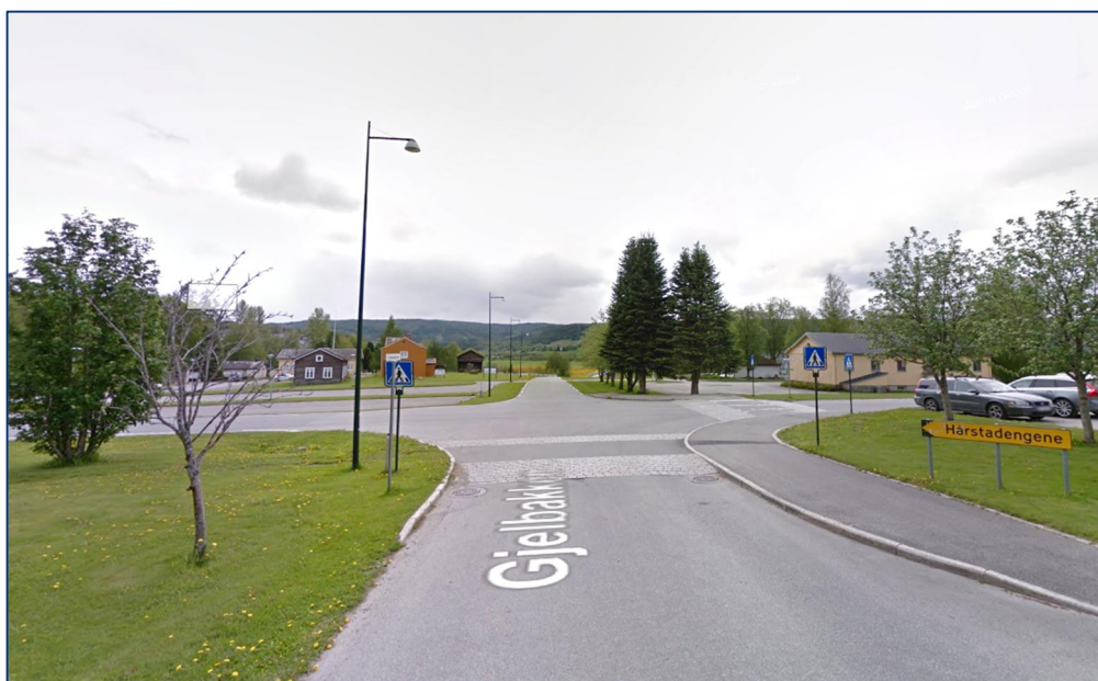
Figur 5: Tilrettelagt kryssingspunkt ved krysset Kvellovegen/Gjelbakken
