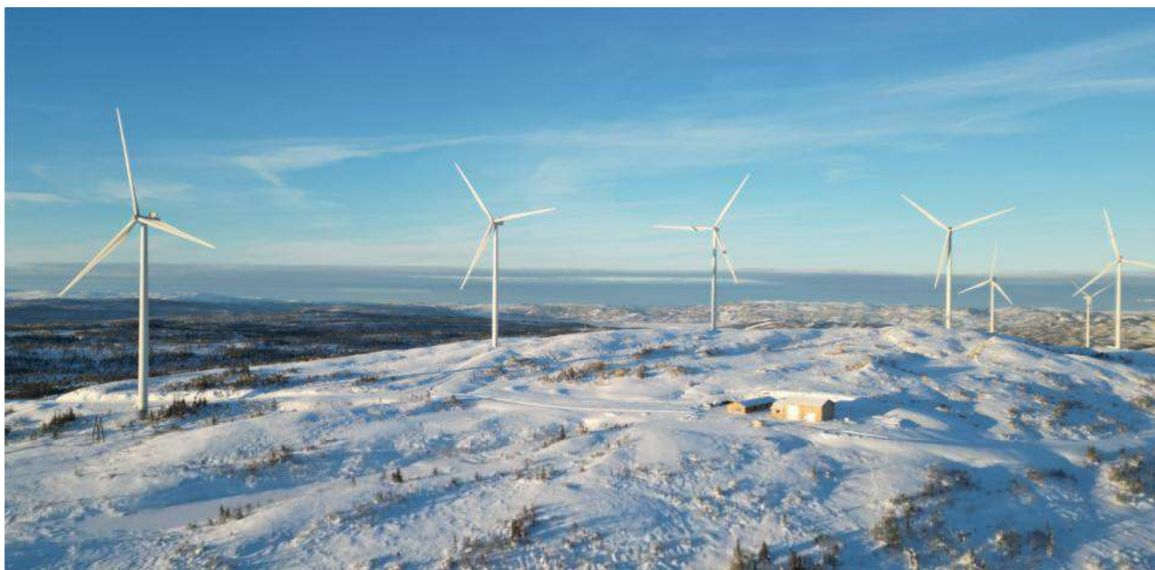
Figur 4 Dagens vindkraftverk Stokkfjellet 1 med servicebygg og trafostasjon i forgrunn. Kilde: Aneo
