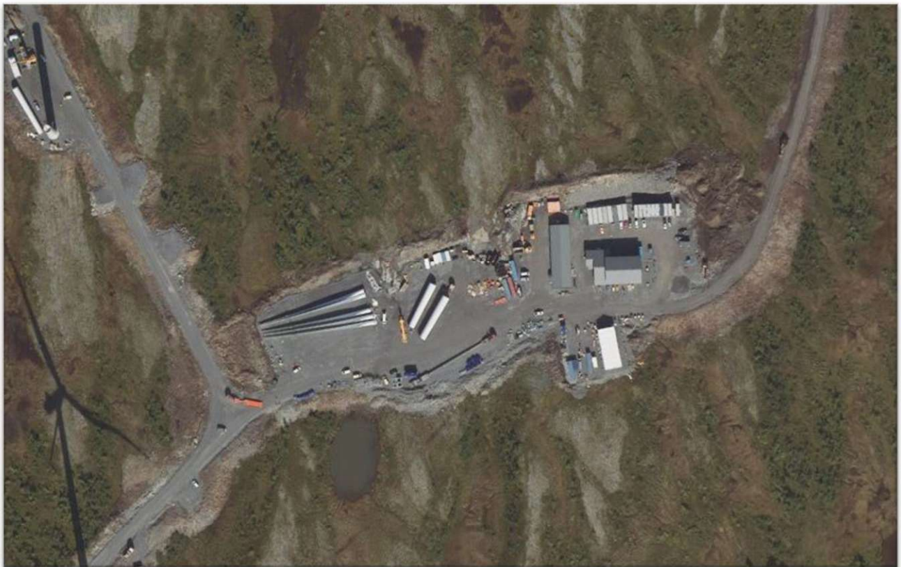
Figur 20 Ortofoto av riggområdet slik det var benyttet ved utbygging av Stokkfjellet 1 i 2019 - 2021. Kilde: Norgeskart
