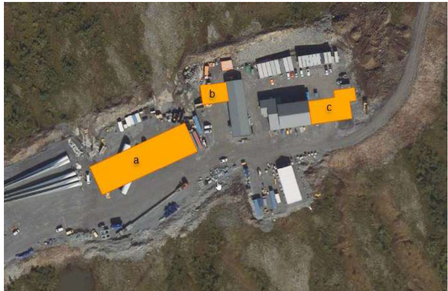
Figur 17 Planlagt utvikling av Stokkfjellet vindkraftverk med nytt bygg for a) batterianlegg, b) utvidelse av servicebygg og c) utvidelse av trafostasjon.
