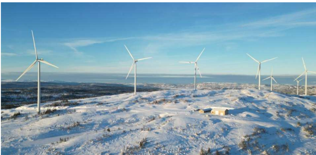
Figur 2 Dagens vindkraftverk Stokkfjellet 1 med servicebygg og trafostasjon i forgrunn
