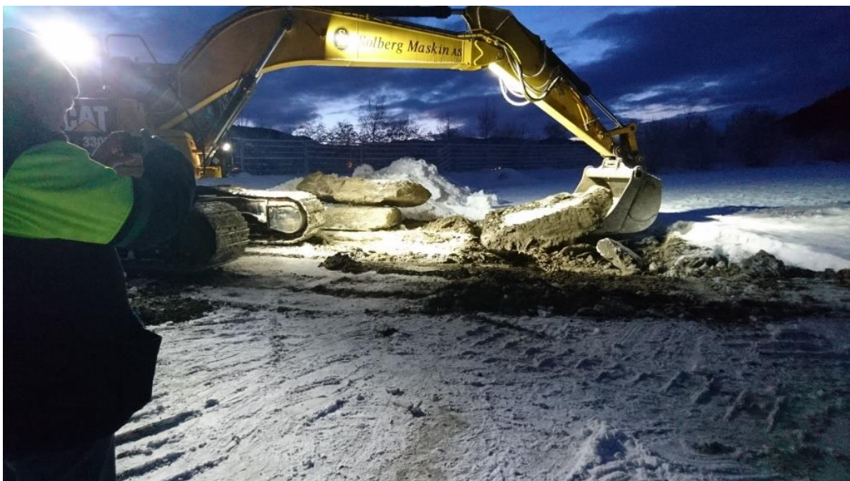
Figur: Anleggsteknisk operasjon ved vinterdrift. Matjorda tas opp og transporteres i form av teleklumper.
