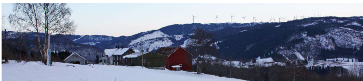
Figur 5-15. Sett fra Lien, er ett av stedene innenfor delområdet der eksponeringen er størst. Fotobearbeida bilde viser planlagt vindkraftverk med utvidelsen som nå utredes. Tiltakets utbredelse vil bli noe større enn i dag. Bildet kan sees i sammenheng med Figur 5-14, tatt fra samme område, om lag 1,5 km nærmere Stokkfjellet (Bilde: Rambøll, 2013).
